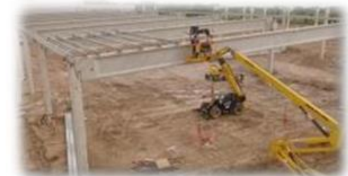
↑ 建屋工事の状況（アルゼンチン）
